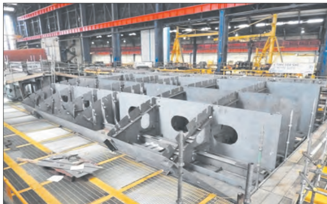
Этап строительства второй секции головного фрегата «Глазго»
